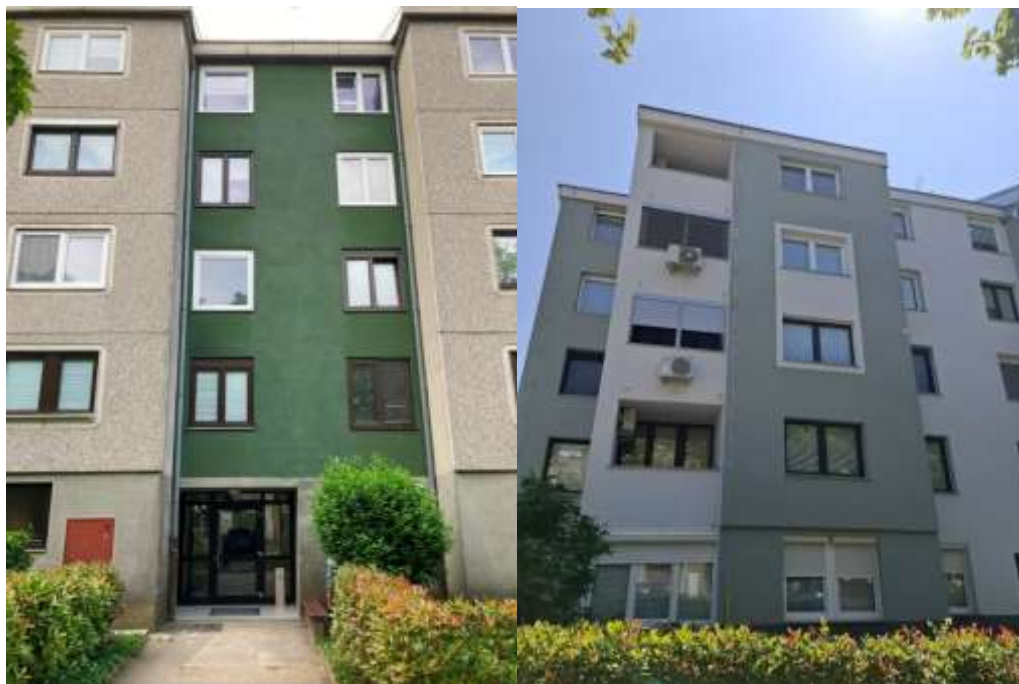
Slika 8 Fotografija fasade pred in po obnovi
