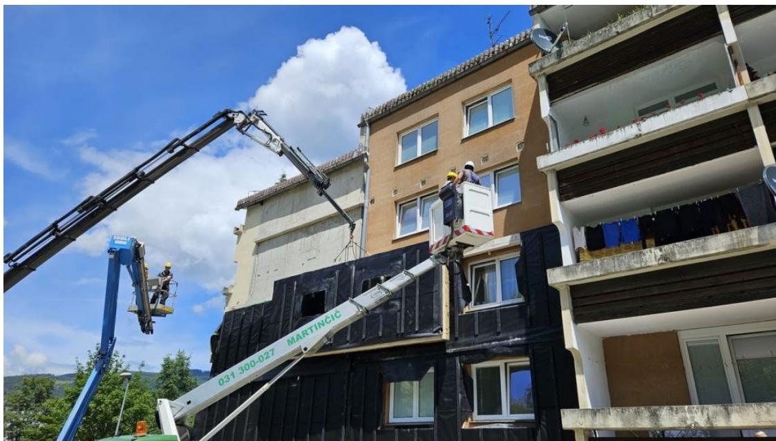
Slika 1: Montaža večnamenskega modula na stavbo v Ravnah (Infinite Building Renovation, 2024a)
