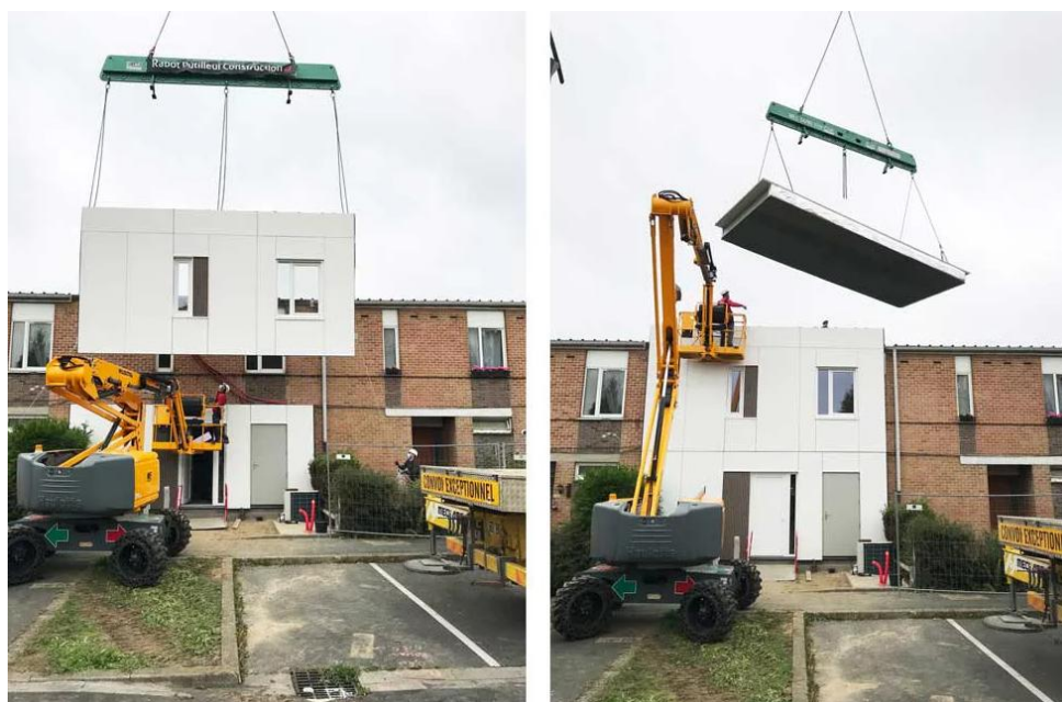
Slika 13 Nameščanje fasadnih panelov (Vir: https://retrofitt.be/en/applications/wattrelos-retrofit/ )
