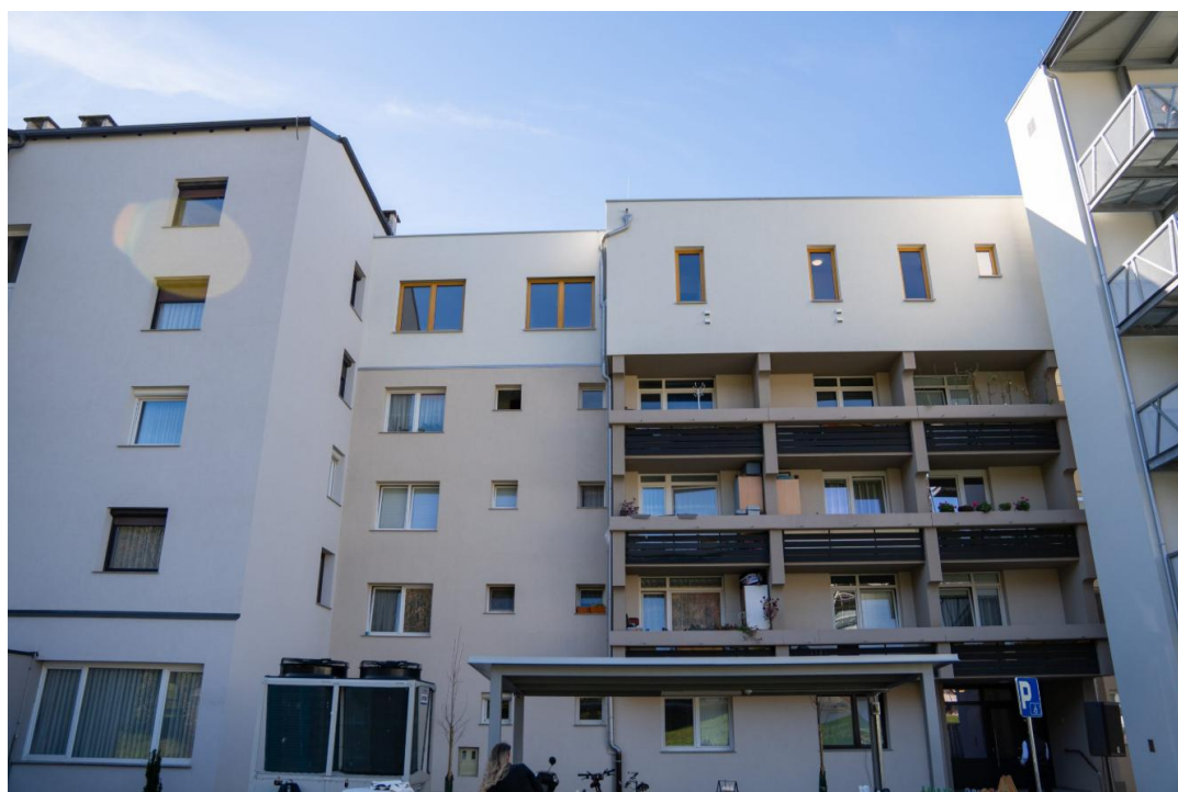
Slika 10 Prenovljena in nadzidana stavba (Vir: Koroške novice)
