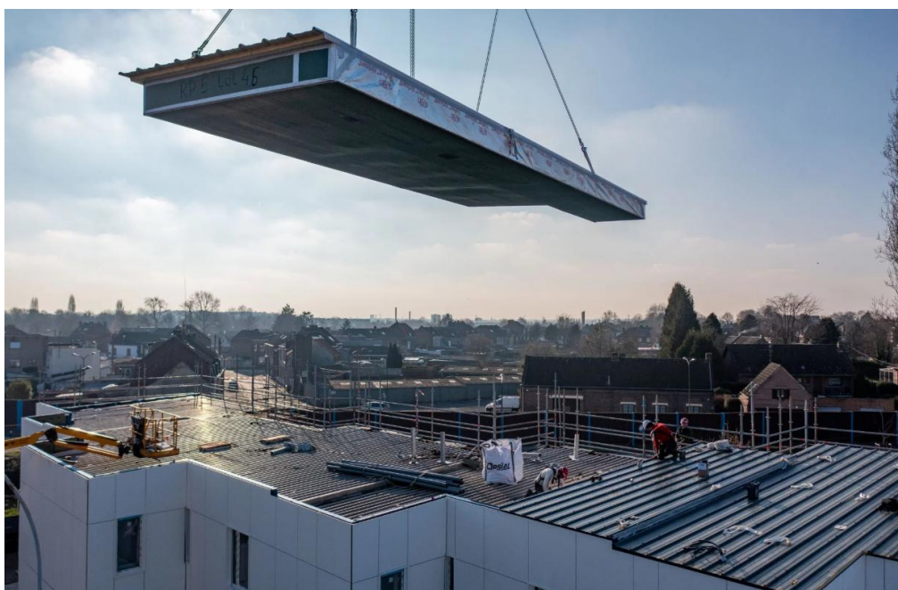
Slika 14 Nameščanje strešnih panelov (Vir: https://retrofitt.be/en/applications/wattrelos-retrofit/ )
