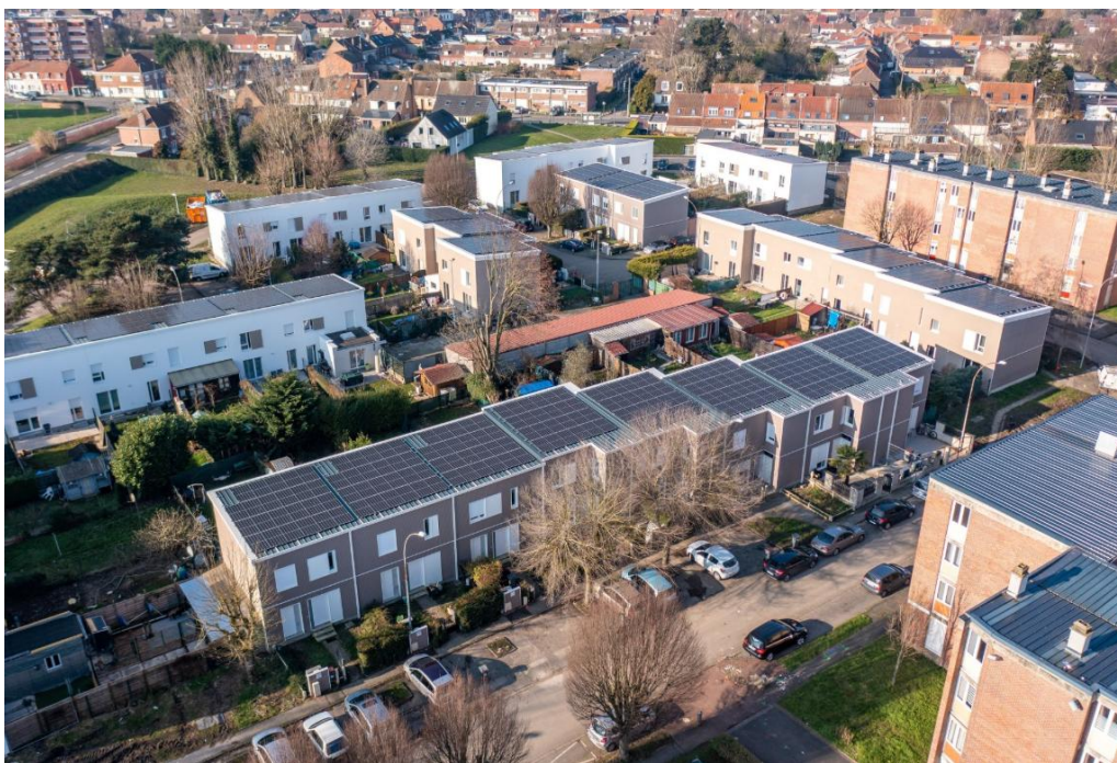
Slika 16 Pogled na prenovljeno sosesko (Vir: https://retrofitt.be/en/applications/wattrelos-retrofit/ )
