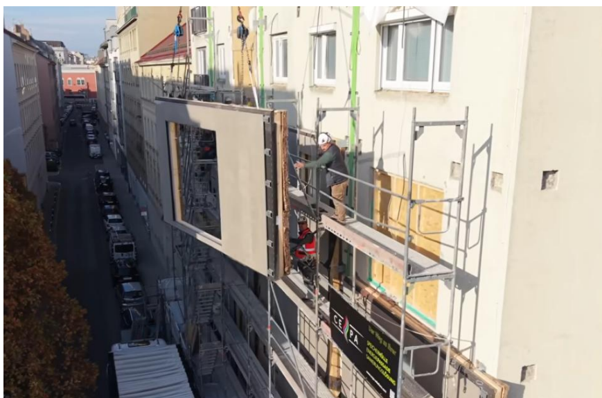
Slika 12 Nameščanje fasadnih panelov (Vir: zajem zaslona https://www.youtube.com/watch?v=e59mJXooszE )
